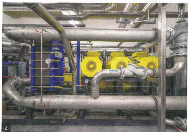
1 - Situé à Cergy (Val-d'Oise), l'Aren'Ice abrite deux patinoires de 1 800 m 2 et les bureaux du Centre national de hockey. 2 - D'une puissance de 1 mégawatt, le système de production de glace utilise de l'ammoniac. Ce fluide dégage énormément de chaleur, laquelle est récupérée pour chauffer le site.
