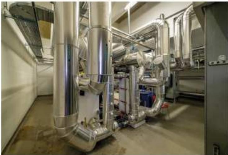
L'ensemble des canalisations sur le circuit NH<sub>3</sub>, mais aussi sur le circuit eau glycolée jusqu'à l'entrée dans les dalles froides et chaudes est en acier inoxydable.
