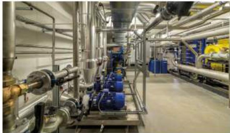
Les huit pompes de l'installation ont été fournies par KSB et sont pilotées par des variateurs de fréquence déportés.
