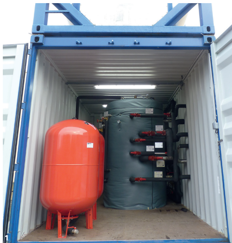
1 Récupérateur de chaleur à droite, vase d'expansion à gauche, volume de stockage d'énergie en haut. 2 Pompe de circulation Salmson ; échangeur à plaques jointés. 3 Vannes de coupure et by-pass Danfoss.
