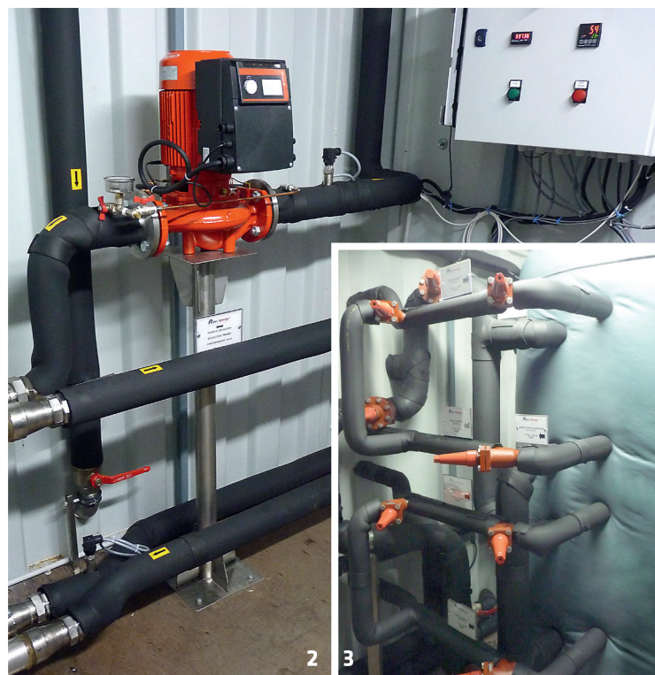
1 Récupérateur de chaleur à droite, vase d'expansion à gauche, volume de stockage d'énergie en haut. 2 Pompe de circulation Salmson ; échangeur à plaques jointés. 3 Vannes de coupure et by-pass Danfoss.
